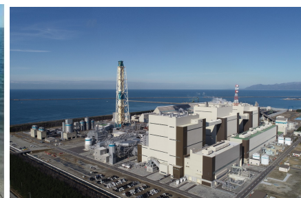
能代火力発電所 （アンモニア混焼・専焼へ向けた実証等）
